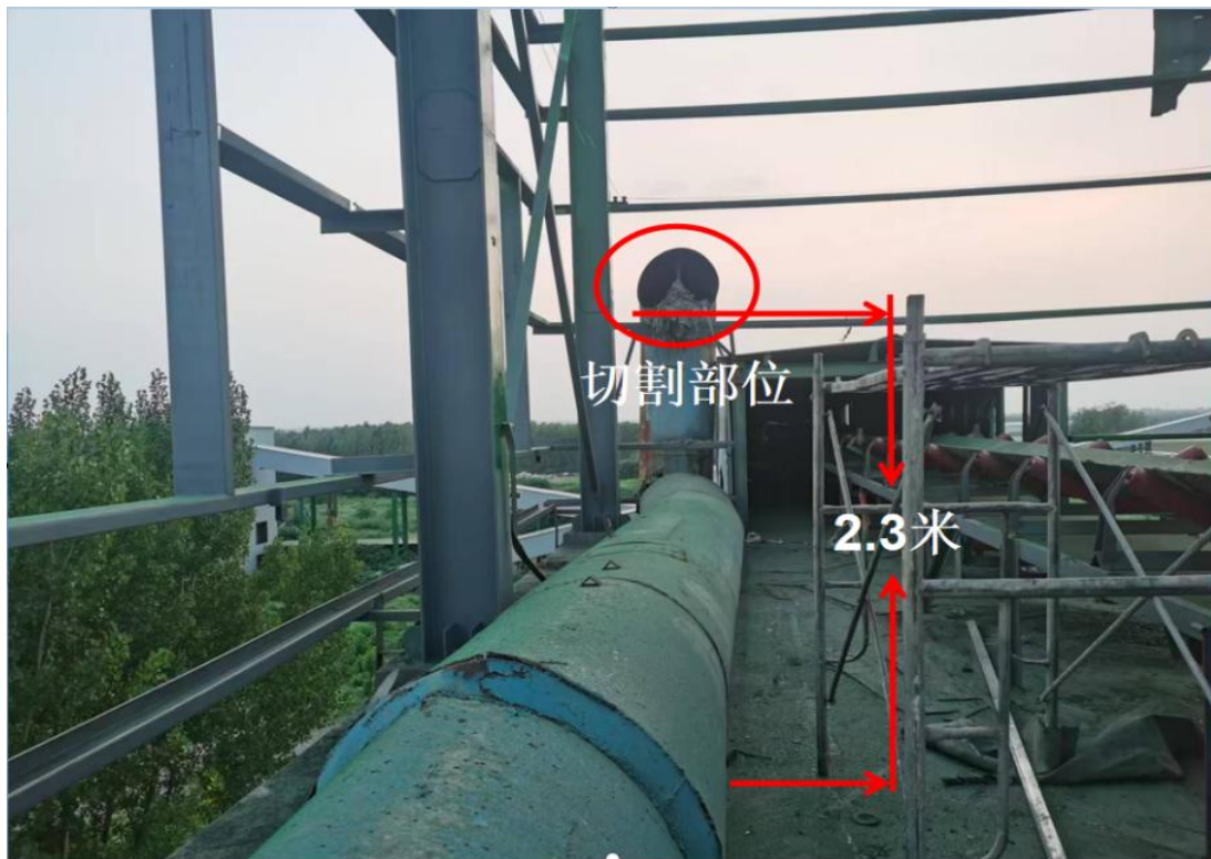
图 2 三楼除尘管道切割位置
