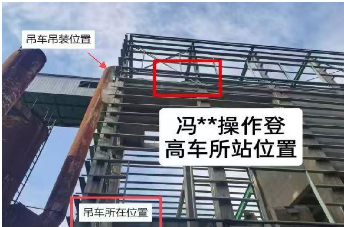
图 3 冯**在登高车操作平台作业时的高度及位置
